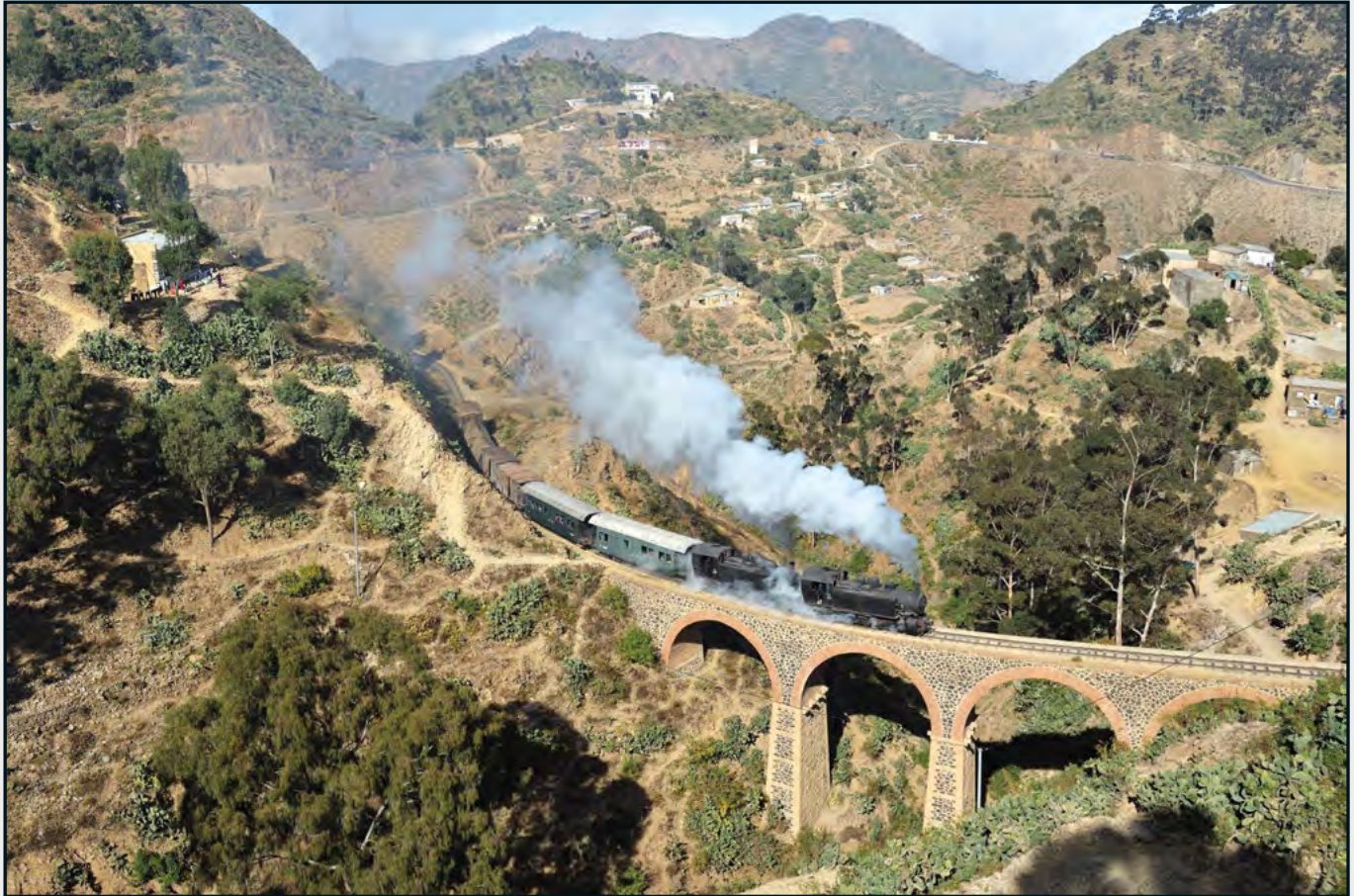
Unser Zug befährt das bekannte Viadukt von Shegerini in Doppeltraktion.
